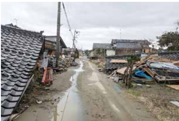
発災後の珠洲市内の様子
